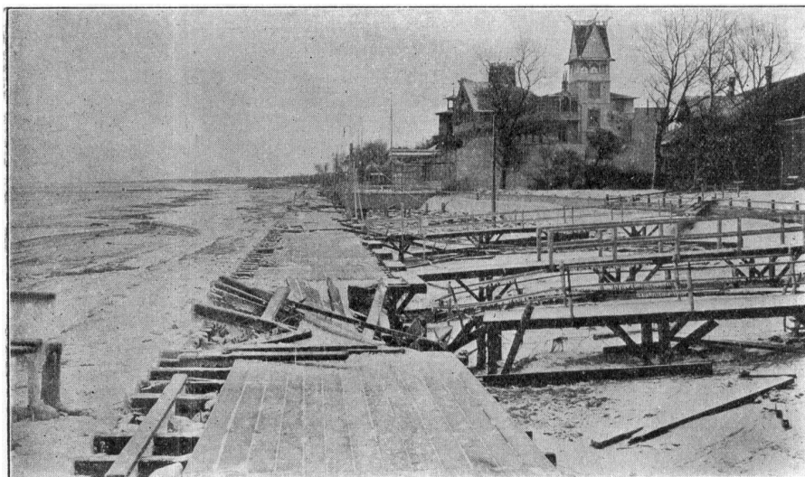
Рис. 3. Разрушения променада в Кранце от волнового воздействия во время шторма 9–10 января 1914 г. [43]
